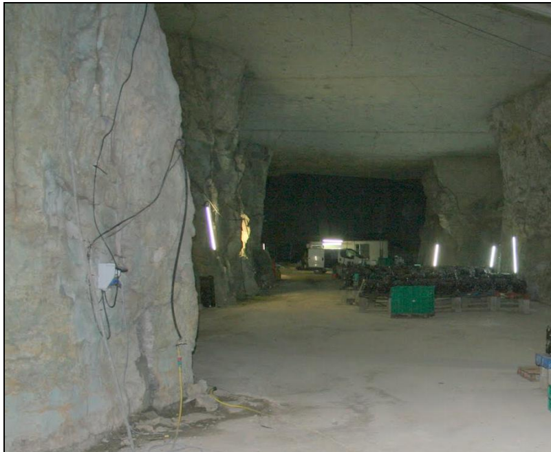
Figure 21 : chambres et piliers de la carrière de Cornelle creusés dans les marnes des Monts d'Ain. Noter la qualité du toit constitué par les calcaires bicolores de la fin du Jurassique moyen.
